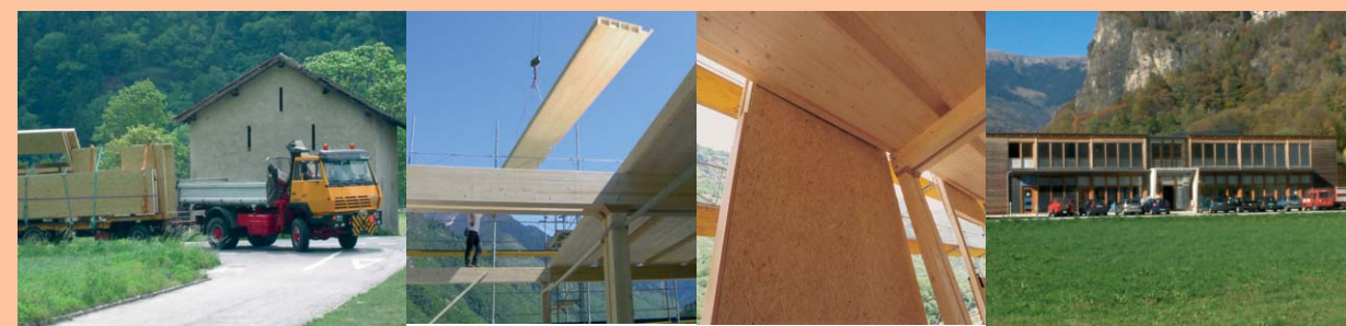
Dongio, stabile commerciale, fasi di montaggio del complesso, durata: 8 settimane
